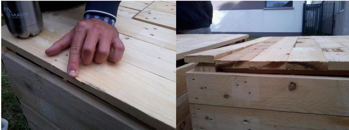
Figure 66: A gauche, des fibres en saillie pouvant provoquer des échardes. A droite un point de faiblesse identifié sur les toits des premiers modèles (Compostous 1.1).
