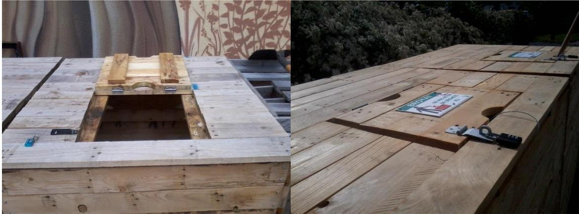
Figure 68: Pour en restreindre l'accès à 15 utilisateurs maximum, ce Compostou a été équipé de charnières, de porte-cadenas et de cadenas d'un modèle ne convenant pas à l'extérieur (à gauche à La Riche), rapidement remplacé par un modèle plus résistant (à droite à Reugny).
