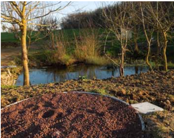
Bassin avant plantation
