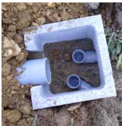
Premier regard répartiteur avant étanchéité
