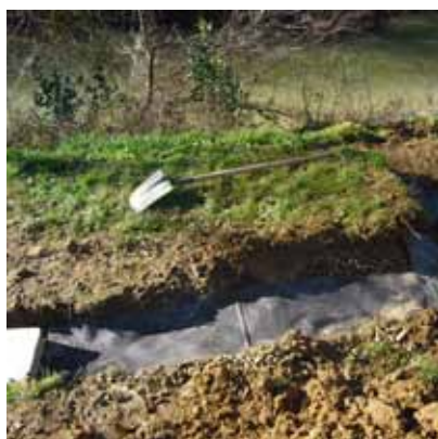
Pose de la bâche EPDM
