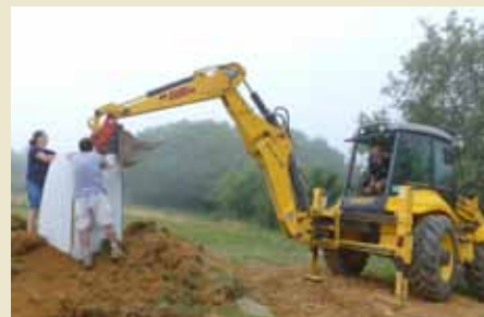
Démarche de projet, écodiagnostic, chantier
