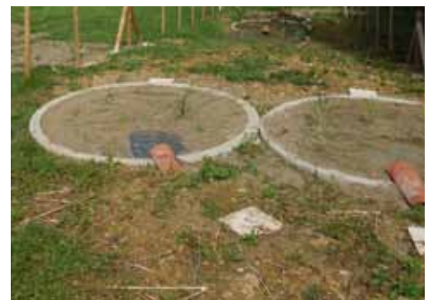
1 er niveau de traitement vertical
