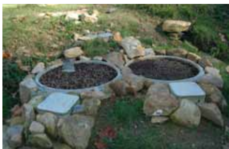
1 er niveau de traitement vertical aérobie fonctionnant en alternance et par bâchée
