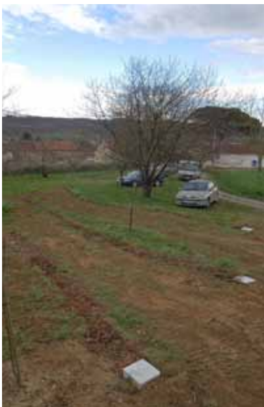
Tranchées remplies de BRF
