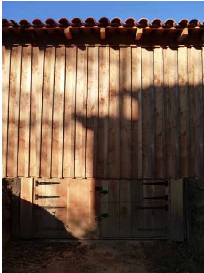
Vue d'ensemble : composteur et mur de la maison
