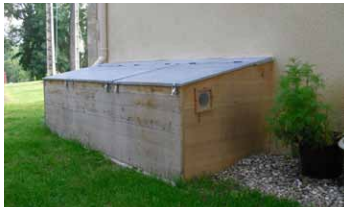
Modèle de composteur isolé et sa ventilation installé à la Maison éclusière de Graziac
