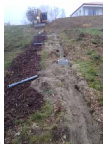
Vue depuis le bas du système avant recouvrement : les tuyaux arrivent au dessus des tranchées remplies de BRF
