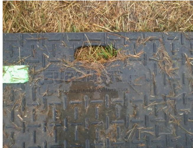
Le revêtement euromat, ou une solution équivalente et moins coûteuse, permettrait de créer des chemins d'accès pour déplacer des conteneurs à déchets sur quelques dizaines de mètres, jusqu'aux bennes les plus proches.
